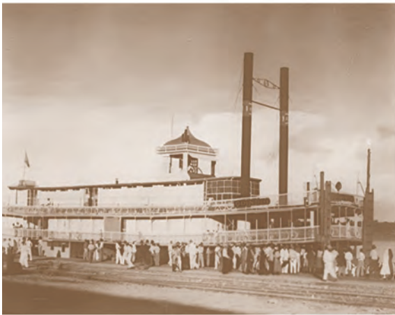
■ Bocas de Ceniza, de donde zarpaban los barcos a vapor por el río Magdalena.
