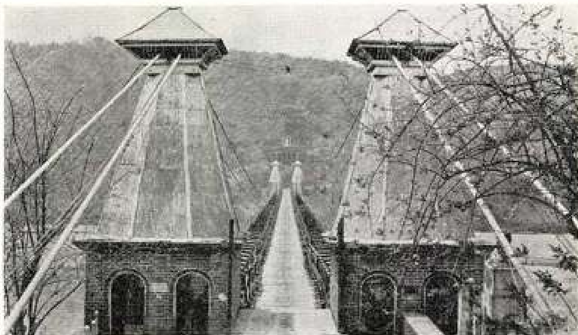
Uno de los más bellos puentes colgantes sobre el río Cauca, carretera Medellín-Turbo, construido en 1895 por el ingeniero sepetranés José María Villa.
