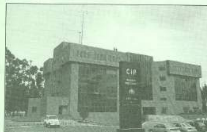
Figura 5. Infraestructura Física y Postura Tecnológica
